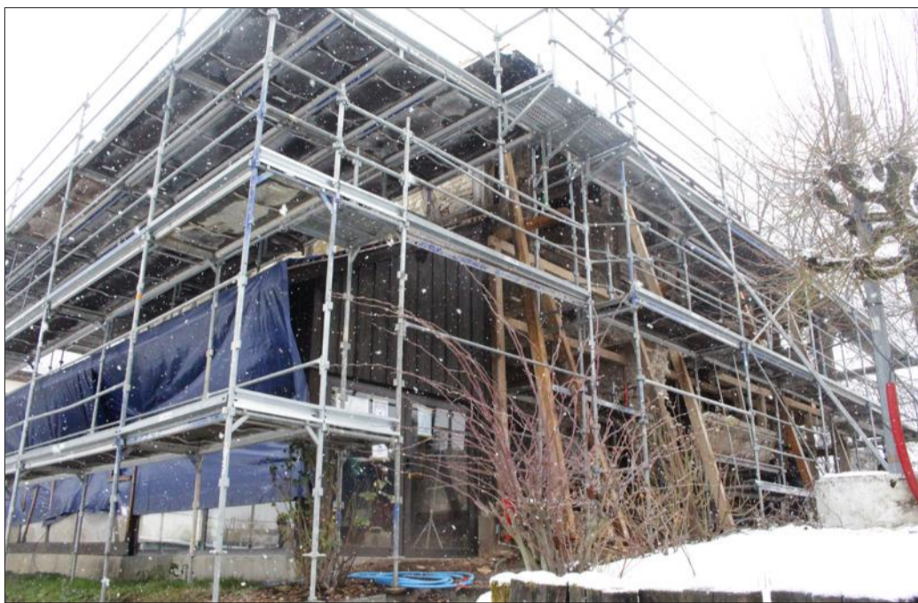
La maison Perronne sous la neige et ouverte aux quatre vents en cette fin janvier. Le chantier de restauration démarré à l'été doit se poursuivre jusqu'à la fin de l'année. Photos L'Alsace/V.M.
